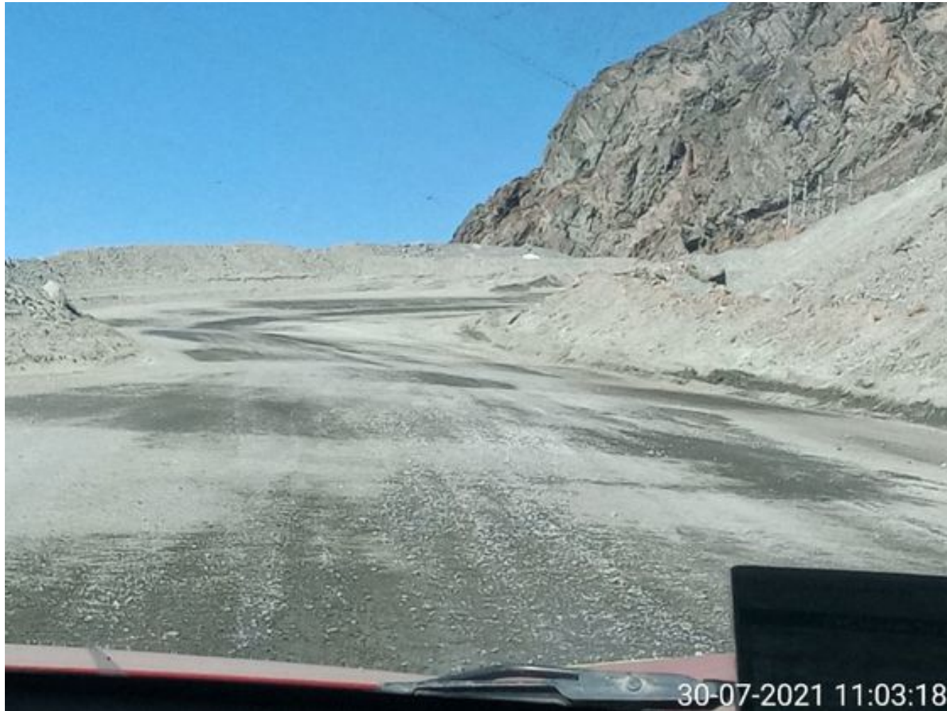
Foto 9: Medida: Riego de caminos EPSA Cerro Amarillo. Lugar: Fases superiores. Comentarios: rampas con riego entre cortado con 1 camión aljibe epsa operativo, fuente de emisión tránsito de Caex
